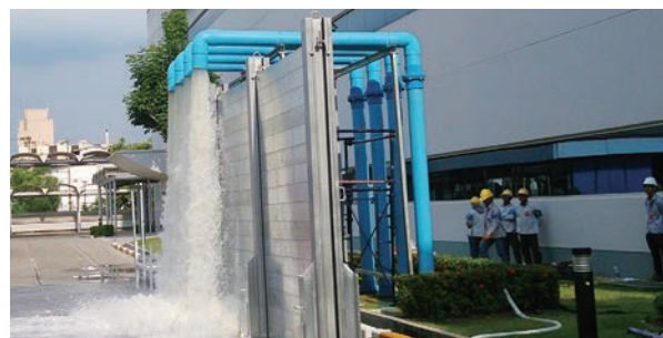
タイの生産拠点におけるBCP訓練の様子(止水壁の組み立てと排水ポンプの起動訓練)
