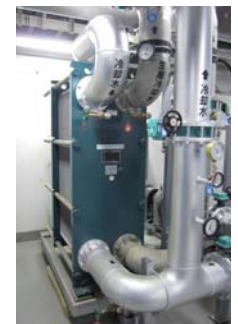
外気による冷却システム
