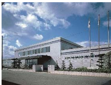
■製造品目 金型、リードフレーム
